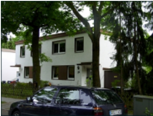
Bild 1: Wie bei jeder Sanierung gab es auch beim Berliner Doppelhaus in Wannsee einen konkreter Anlass: Die Heizungserneuerung, die Flachdachsanierung und die Instandsetzung des undichten Wintergartendaches waren nicht mehr aufzuschieben.
