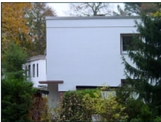
Bild 2: Bereits während der Bauphase bemerkte der Eigentümer des sanierten Berliner Wohnhauses die Komfortverbesserung und senkte die Heiztemperatur im Wohnhaus. Durch die Entsorgung des 4.500 Liter Öltanks wurden acht Quadratmeter nutzbare Fläche hinzugewonnen.
